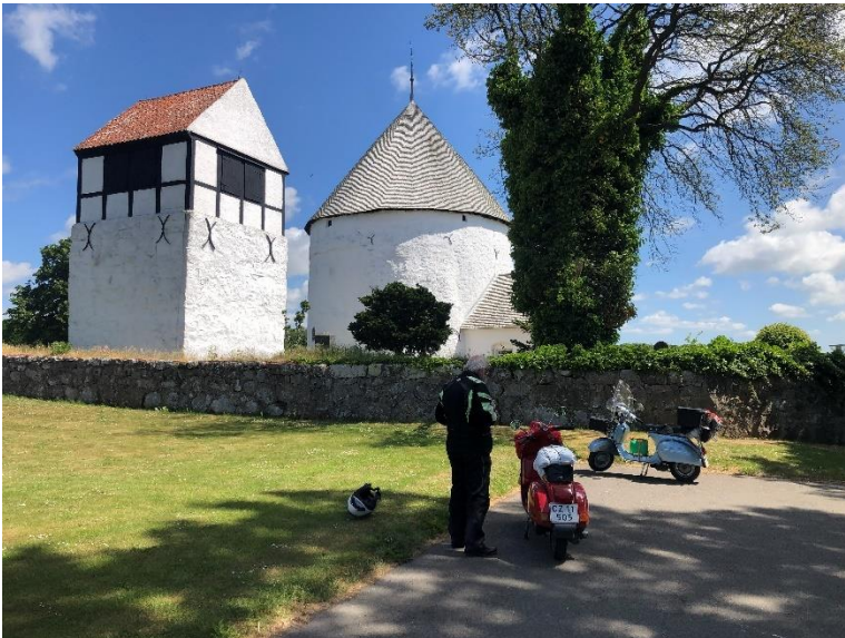
Vestermarie rundkirke, og desværre ikke adgang til tagetagen.
