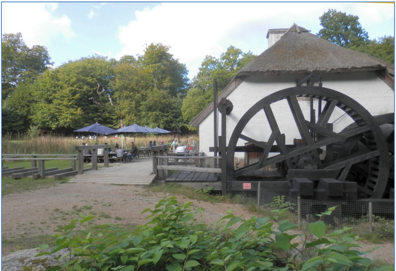
Underfalds skovlhjulene til den gamle vandmølle er smukt restaurerede.
