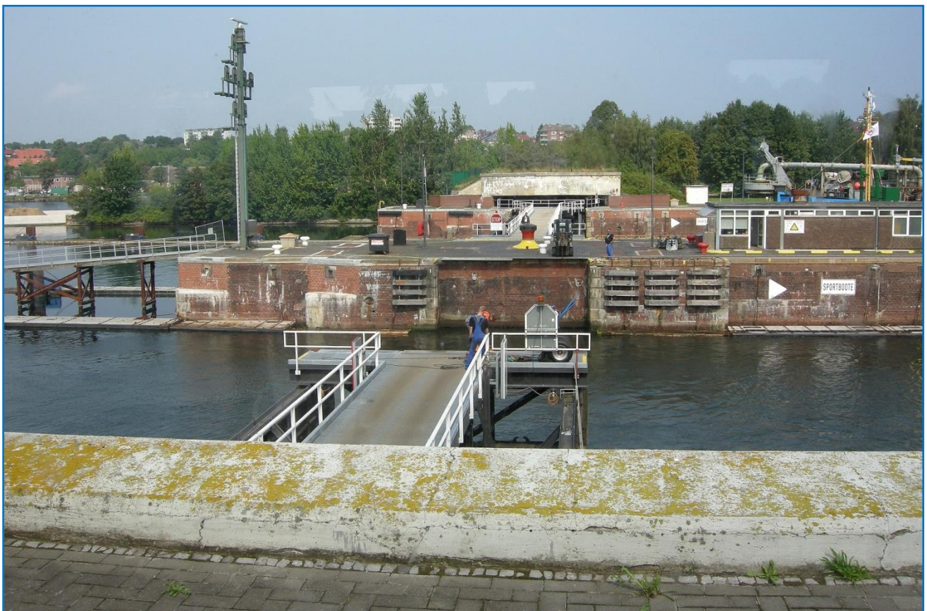
Den store skyde/sluseport bevæger sig ud fra sluseport huset på vej til at lukke slusen (og en smed arbejder samtidig på toppen sluseporten, tyskerne er effektive)
