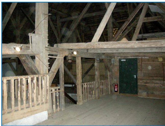
Nogle af de svære stolper og bjælker, der bærer "Roter Haubarg's" store "pyramide"stråtag og loft
