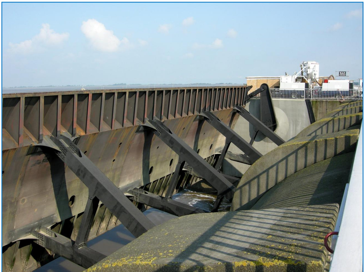
Det svære grej, en sluseport på 40 meter
